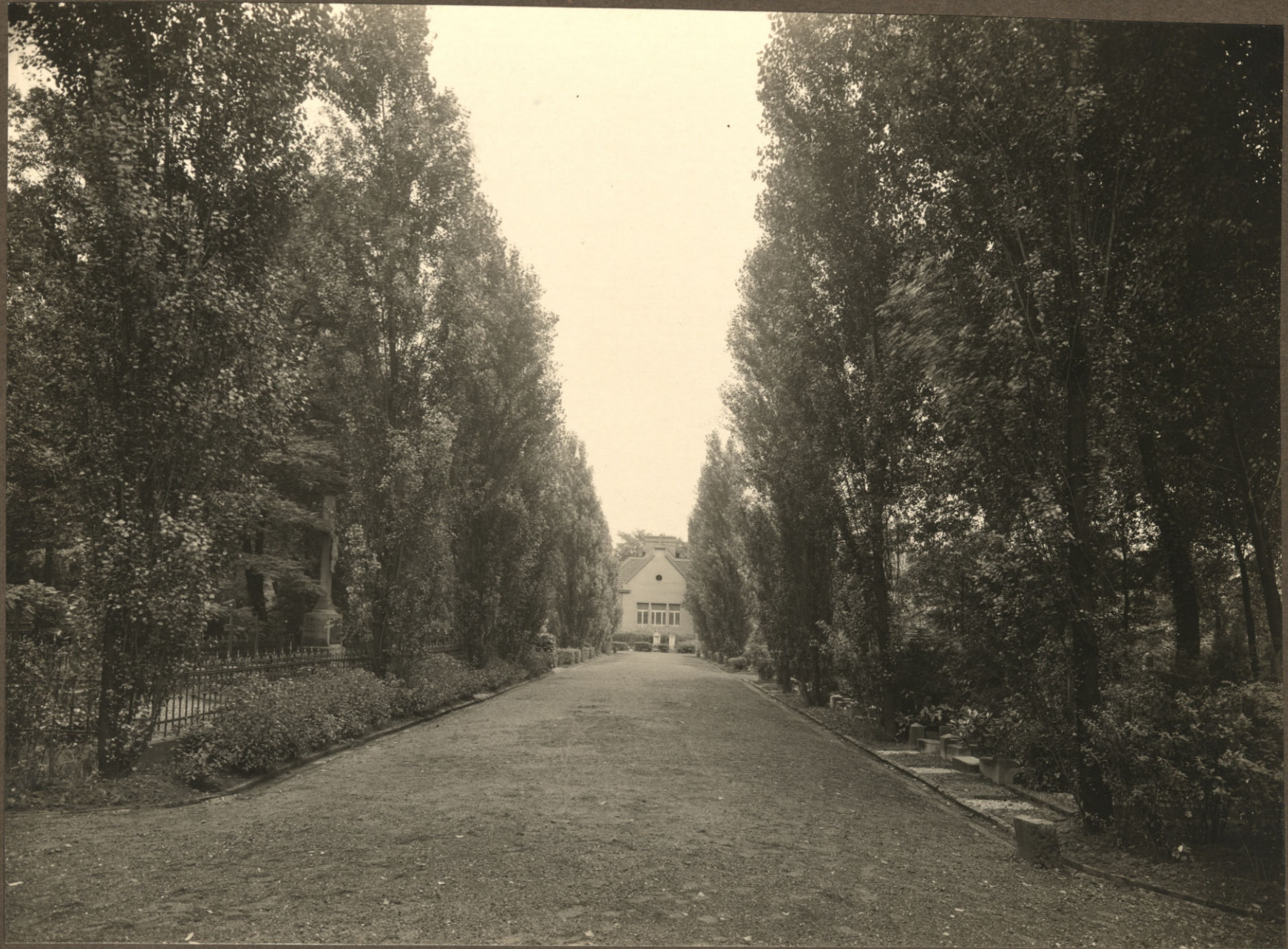
Blick zur Halle
