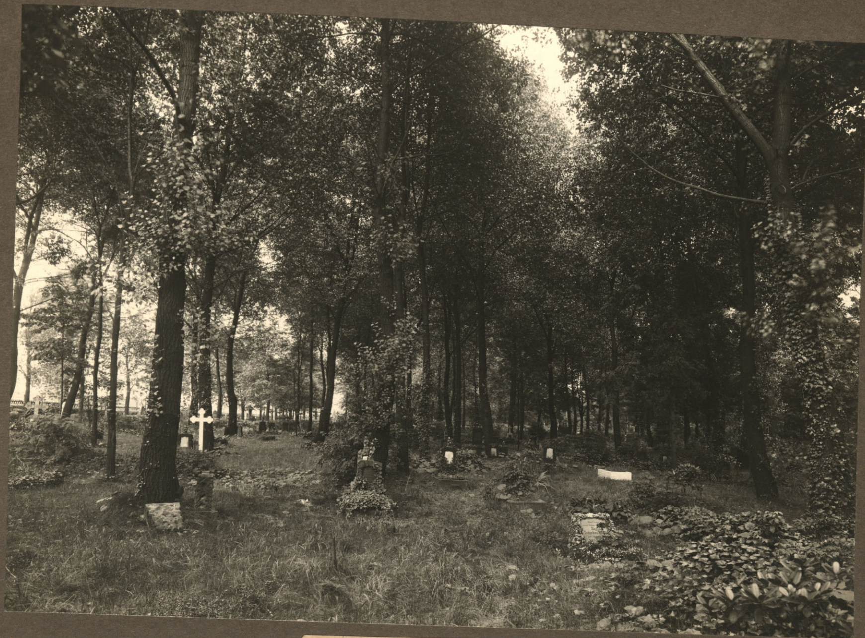
Blick in einer alten Abteilung
