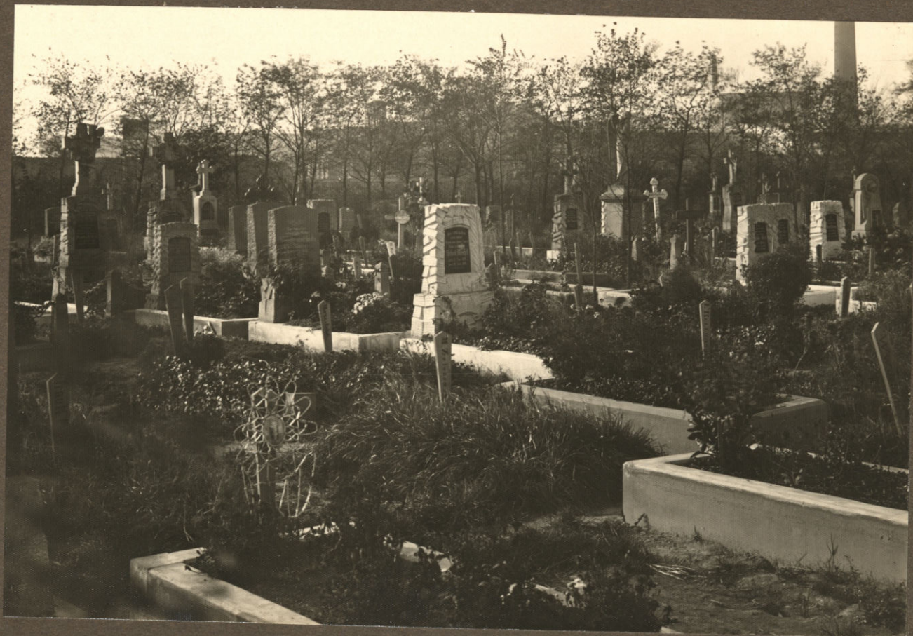
Eine alte Abteilung (früherer Zustand)
